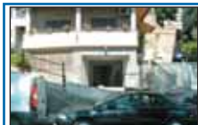
VIALE ITALIA locale mq. 310 in buone condizioni
